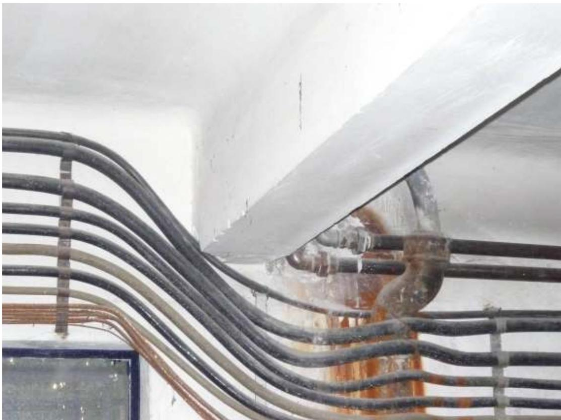
**Φωτογραφία 8** Μικρή βλάβη σε στήριξη δοκού για διέλευση καλωδίων στην οροφή υπογείου
